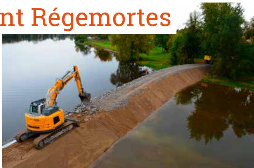
Des travaux ont démarré à l'automne, au niveau de la passe à poissons et dans le cadre des mesures compensatoires qui s'imposent à la réalisation du deuxième pont. L'objectif : remettre les différents bassins à une hauteur raisonnable, afin de permettre le franchissement du radier aux espèces de poissons à faible capacité de nage, comme l'Alose.
