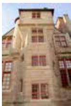
Façade du Doyenné, Moulins
